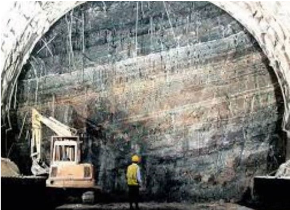
Figure 1.3. TGV Sud Est – Tunnel de Tartaignille – Application de la méthode ADECO RS avec soutènement du front de taille par des boulons en fibre de verre (P. Lunardi)
