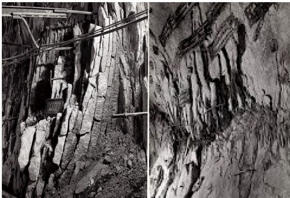
Tunnel du Mont Blanc – Ruptures brutales en paroi ( Rockbursts )
