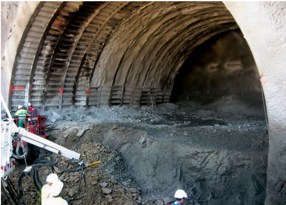
Figure 1.2. Tunnel 186 – Creusement traditionnel en demi-section
